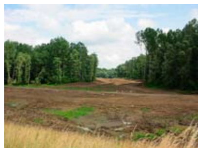
Készül a bevezető csatorna
