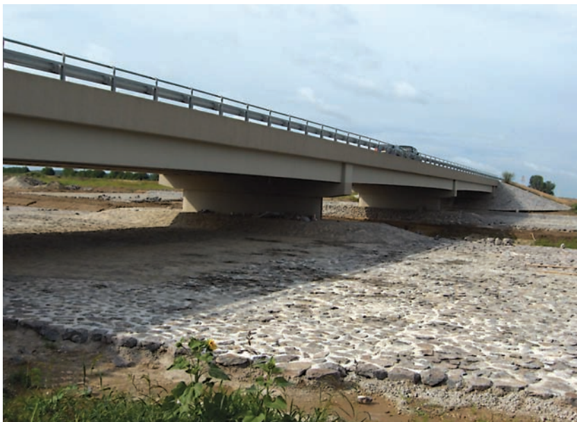
A projekt során megemelt 3804 sz. országos közút beeresztő csatorna feletti hídja
