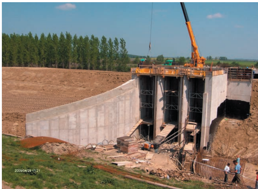
Az épülő déli műtárgy
