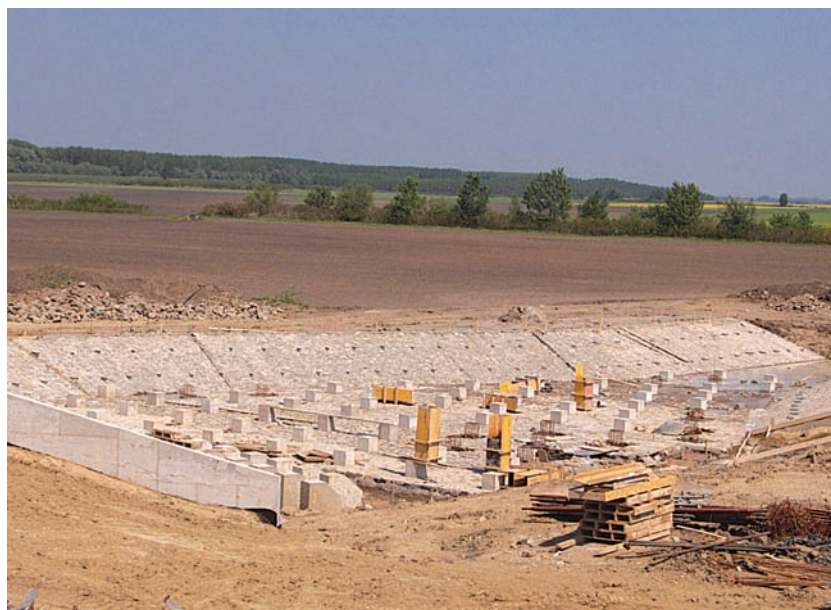
A déli műtárgy épülő energiatörő medencéje
