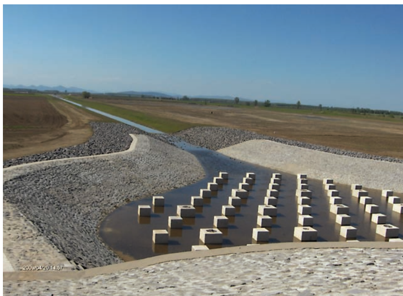
Energiatörő tüskék a beeresztő műtárgy csillapító medencéjében
