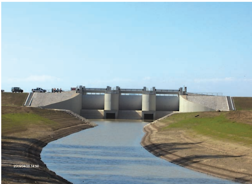
A műtárgy a beeresztő csatornával a Tisza felől
