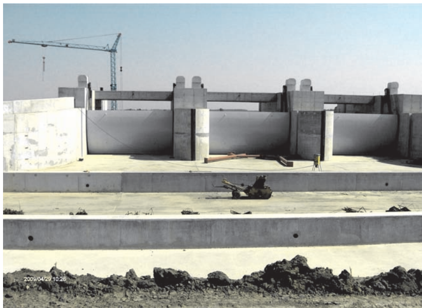
Az északi műtárgy szegmenstáblái a hullámtér felől
