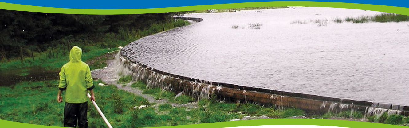
Szivárgó faanyag gátra épített tározótó a lefolyás lassú elvezetésére - Belford Burn projekt
