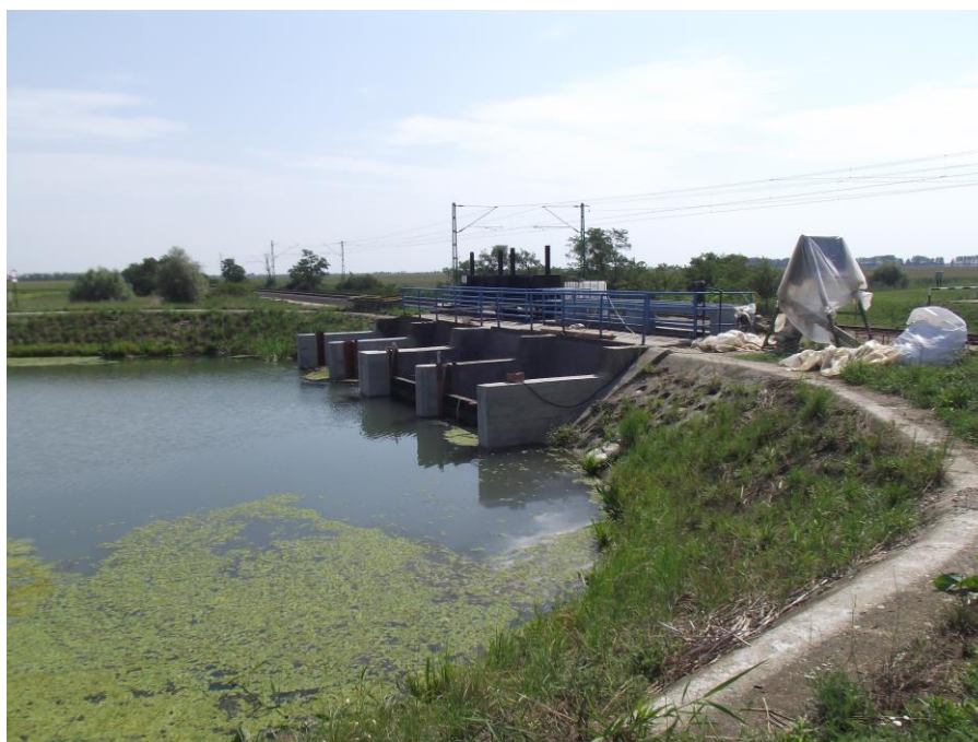
Nagyunsági-főcsatorna (forrás: http://www.komplextiszato.hu/index.php/galeria )
