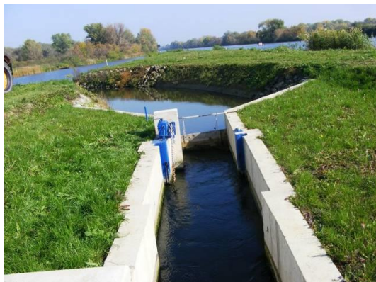
A hajózóágból induló hallépcső öble és az elzáró szerkezet
