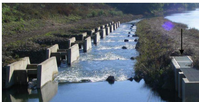
A csalivíz a hallépcső melletti kibetonozott csatornában fut és a földnyelv végénél ömlik nagy sebességgel a hallépcső vizébe.
