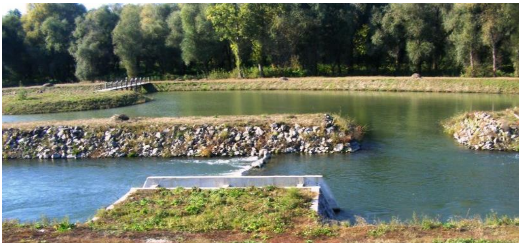
A középső pihenő tóban egy kimélyített mederszakasz, ún. halágy szolgál teleül. A természetszerűen kialakított hallépcső egyúttal turista célpont. A pihenő tóban kialakított kis sziget a túoldalról egy hídról közelíthető meg. További turisztikai fejlesztéseket is terveznek az üzemeltetők.
