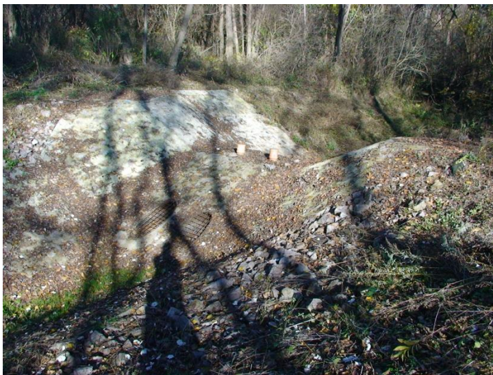
A holtág tiszai végén épített fenékküszöb a vízpótlást és vízszintszabályozást is segítő két acélső beépített tolózárral
