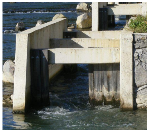
Természetközeli bukók és réselt halátjárók. Utóbbiak mélyküszöbű nyílásai biztosítják alacsonyabb vízjáráskor is a halak számára az átjárhatóságot.
